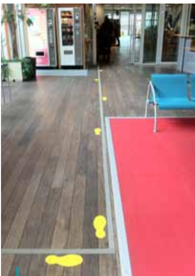
Une bande podo tactile, avec des visuels menant directement à l'accueil (lieu où l'on est sûr d'y trouver assistance humaine).
