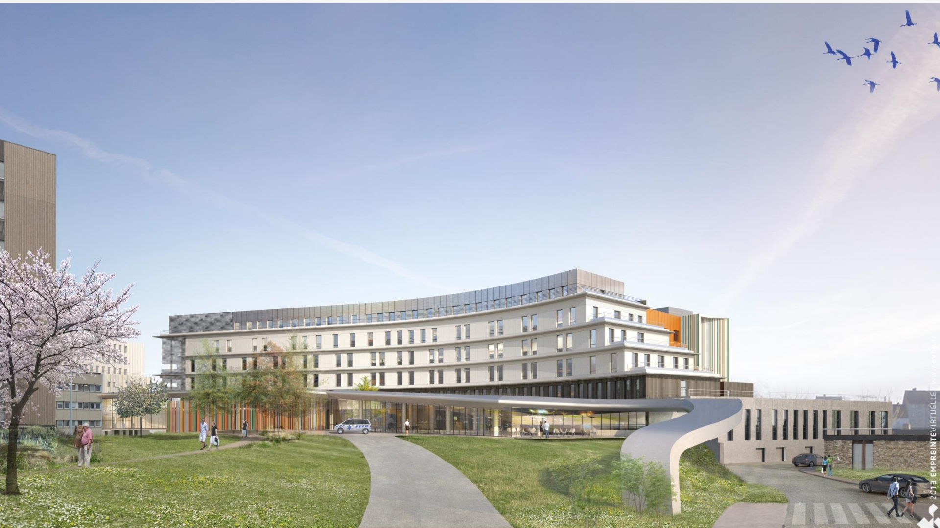
La façade sud de l'IRC et ses accès
