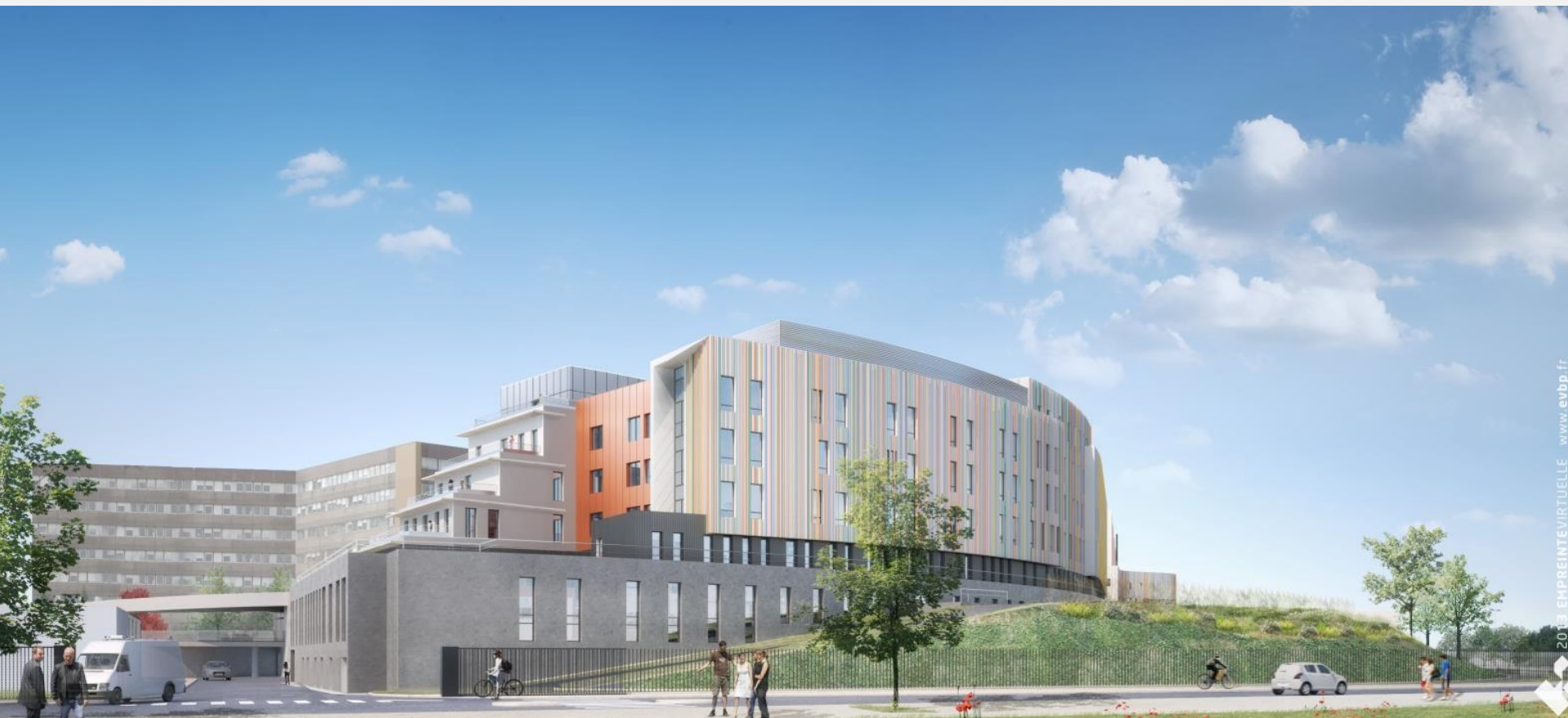
Vue sur l'IRC depuis l'entrée Molière Est
