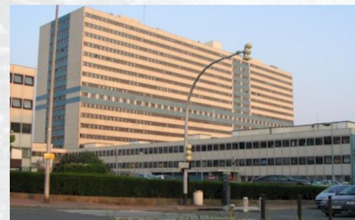
Restructuration ascenseurs Henri Mondor
