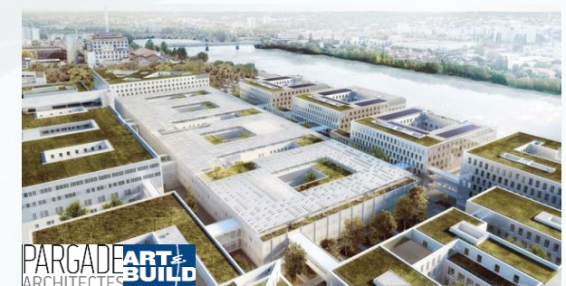
MOE execution sous-traitant de PATRIARCHE.
